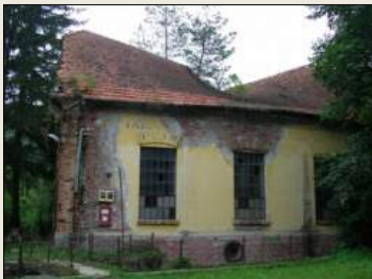
Uzina electrică de pe pâraul Tărlung
